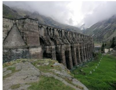
*Sono le 7.15 del 1° Dicembre 1923 quando il guardiano che si trova ai piedi della diga ode come un precipitare di sassi. E' l'inizio della tragedia. Da uno degli speroni si apre una vasta fenditura longitudinale: crolla il pilone centrale e 6 milioni di metri cubi di acqua, fango e detriti, si riversano a valle seminando morte e distruzione.*
